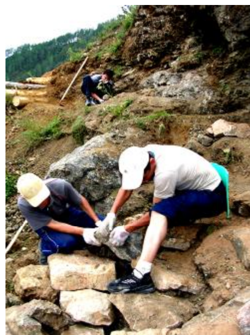
Возведение подпорной стенки
