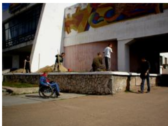
Строительство пандусов в г Улан-Удэ
